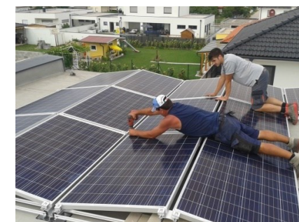
© J. Gansch | eigene PV-Anlage, eNu
